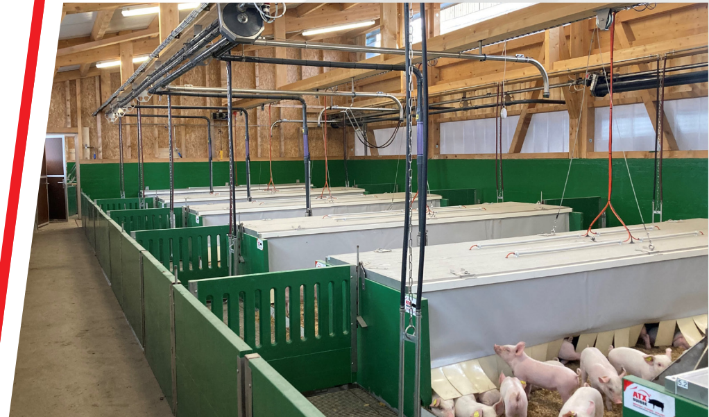
ATX® Aufzuchtstall mit Schlauchfenster
